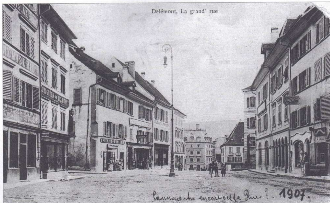
La Grand'Rue; un candélabre électrique; au fond, la Poste.
