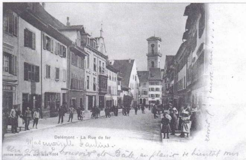
La Rue de Fer; à gauche, la grande maison de commerce Rippstein.
